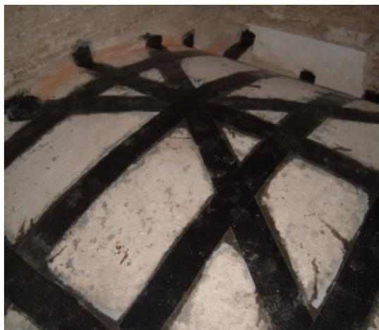
2006. Rinforzo in opera di volta in muratura in immobile vincolato, mediante incollaggio di fibra di carbonio all'estradosso.
